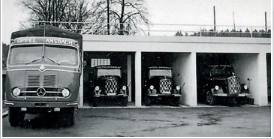
Die Garage in der Oberhäuser Straße wurde später zur Werkstatt umgebaut. Reparaturen führten die Oppels in eigener Regie aus, zunächst leitet Adolf Oppel die Instandsetzungsarbeiten
